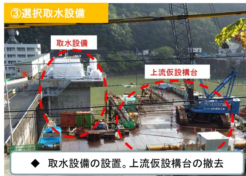
◆ 取水設備の設置。上流仮設構台の撤去
