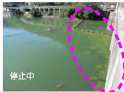
ばっき循環施設により、ダム湖の水を循環させることで植物プランクトンを光合成が起きにくい下層へ移動させます。
